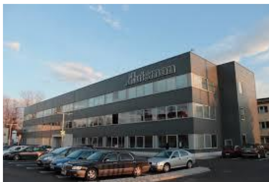
Obr 1 Huisman Konstrukce s.r.o. Sviadnov [1]
